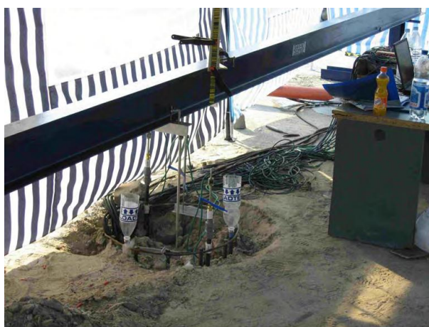
Рис. 3. Общий вид измерительного оборудования на поверхности в процессе испытания сваи
