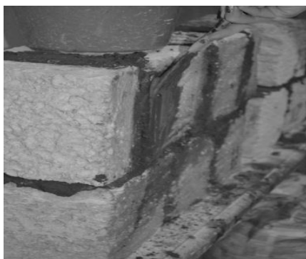
Рис. 1. Рабочий фрагмент нанесения составов штукатурной гидроизоляции
