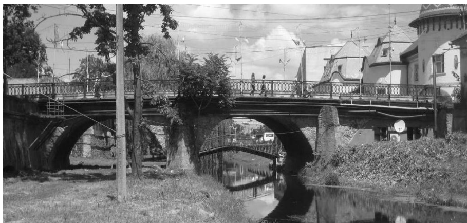
Рис. 1. Загальний вигляд моста
