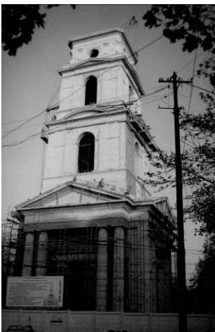
Рис. 8. Оздоблювальні роботи елементів шатру дзвіниці
