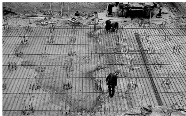
Рис. 4. Влаштування ростверку у вигляді монолітної залізобетонної плити
