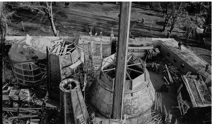
Рис. 9. Елементи шатру дзвіниці готові до монтажу
