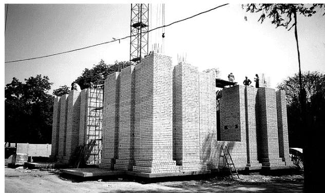
Рис. 6. Початок будівництва надземної частини дзвіниці
