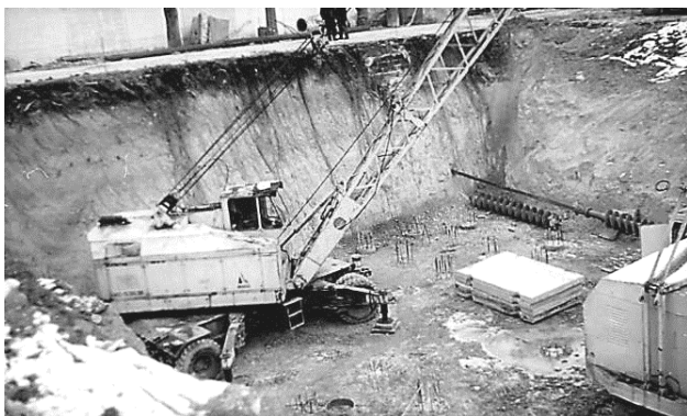
Рис. 3. Влаштування буронабивних паль у котловані дзвіниці
