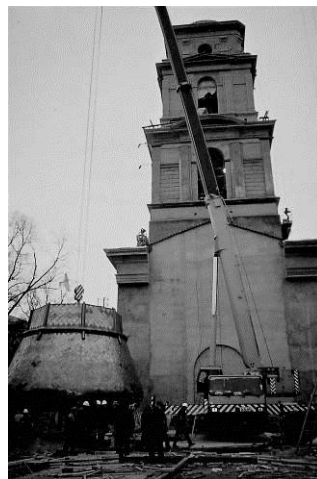
Рис. 10. Монтаж елементів шпиля дзвіниці
