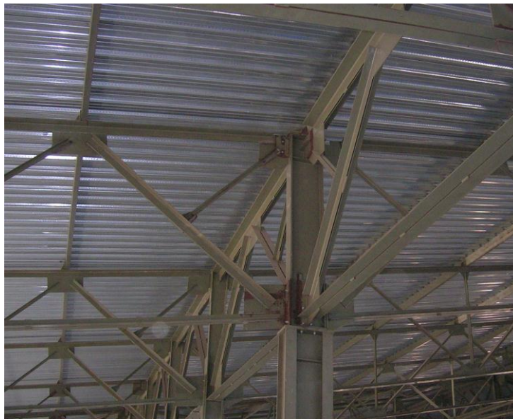
Рис. 1. Фермы с элементами из парных уголков
