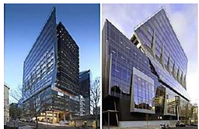
Рис. 21. «Солнечный фасад», Ark Building, Сидней
