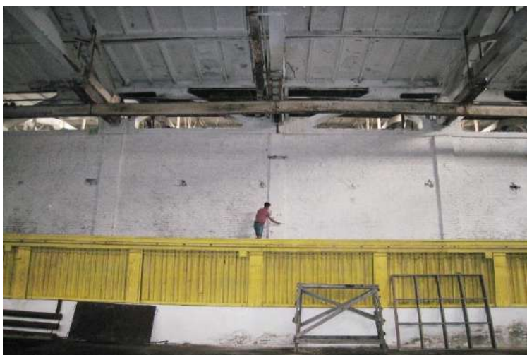
Рис. 1. Визначення міцності бетону колонн склерометром
