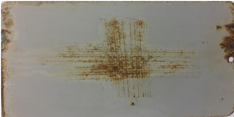
Рис. 5. Корозія лакофарбового покриття складу №3
