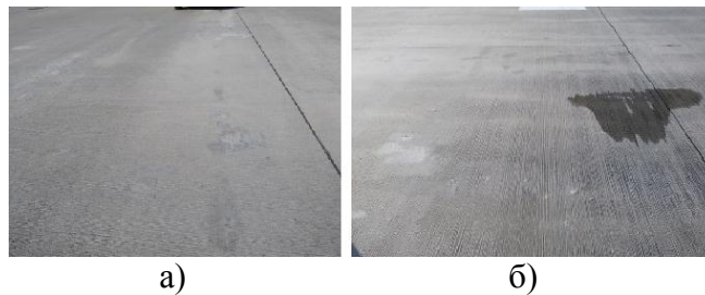
Рис. 6. Вигляд дослідної ділянки ЗПС, обробленої реагентом Ravix CCC100 ® : а – в сухому стані; б – після нанесення води
