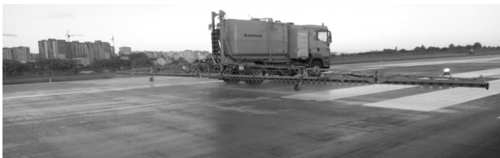
Рис. 7. Оброблення бетонної поверхні ЗПС гідроізолятором Ravix CCC100 ®
