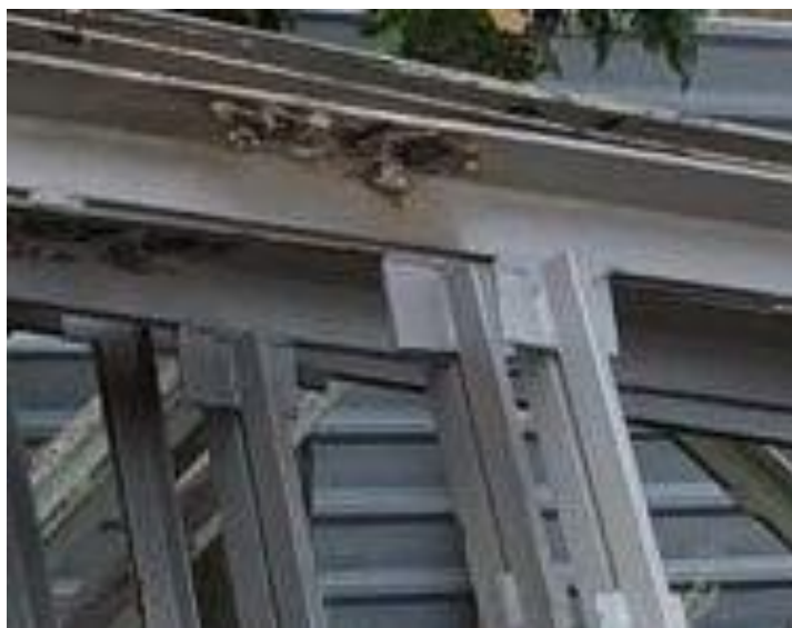
Рис. 2. Пропал отворів у верхньому поясі ферми
