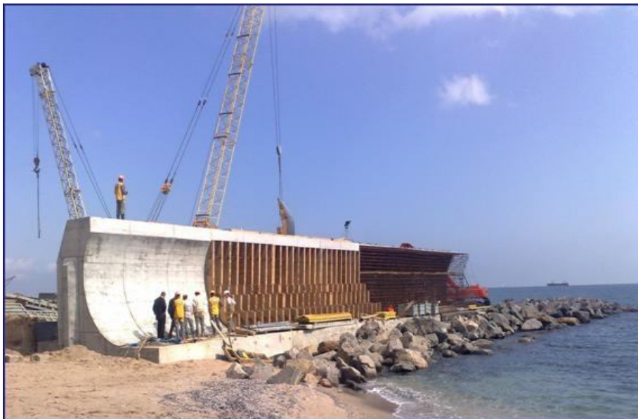
Рис. 3. Сооружение волноотбойной стенки
