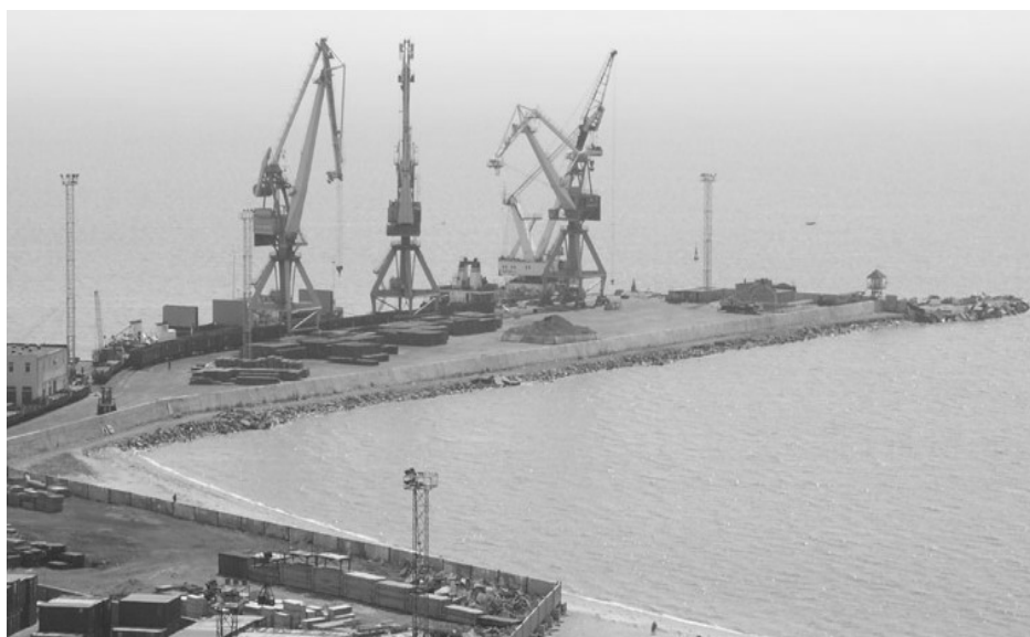
Рис. 3. Искусственная территория причала № 18 с заполнением металлургическими шлаками меткомбинатов Азовсталь и Ильича г. Мариуполь
