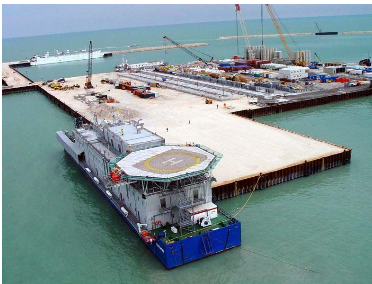
Рис. 1. Искусственный остров с причальными стенками
