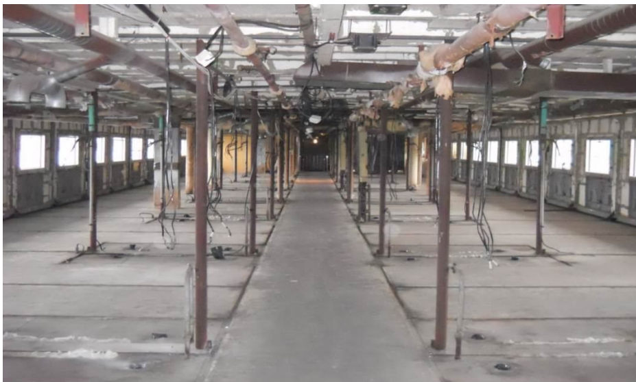
Рис. 4. Пример демонтажа внутренних перегородок на РКПС при модернизации / конверсии
