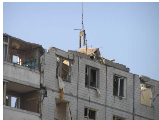
Рис. 3. Розбирання будівлі за допомогою баштового крана: а – вилученням окремих елементів; б – з використанням П-подібного захвата
