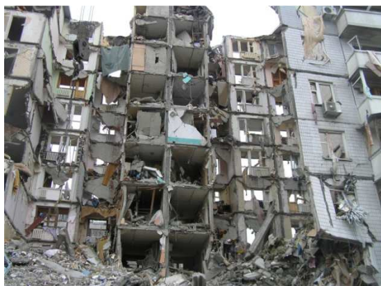
Рис. 2. Зруйнована вибухом газу третя секція будівлі у Дніпропетровську (2007 р.): а – залишки фасада; б – задня стінка
