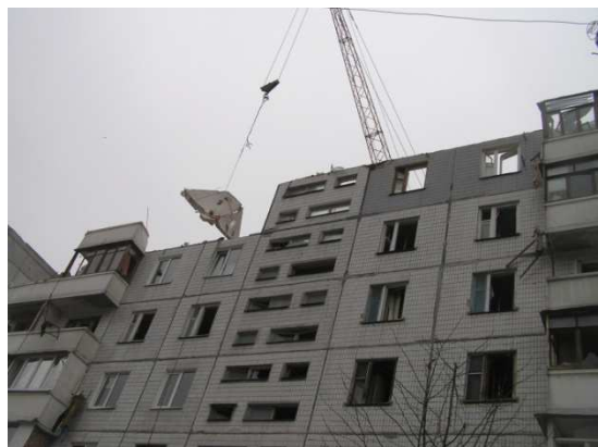
Рис. 3. Розбирання будівлі за допомогою баштового крана: а – вилученням окремих елементів; б – з використанням П-подібного захвата
