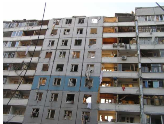
Рис. 2. Зруйнована вибухом газу третя секція будівлі у Дніпропетровську (2007 р.): а – залишки фасада; б – задня стінка
