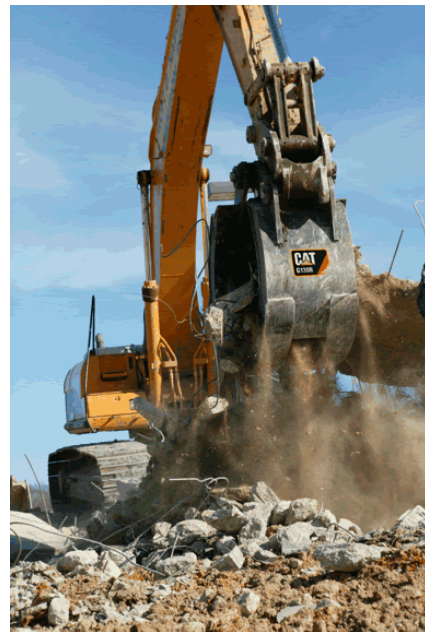
Рис. 1. Використання екскаваторів для розбирання завалу та зруйнованого Торговельного центру у Нью-Йорку: а – з ковшем; б – з ковшем та захватом у вигляді щелепи
