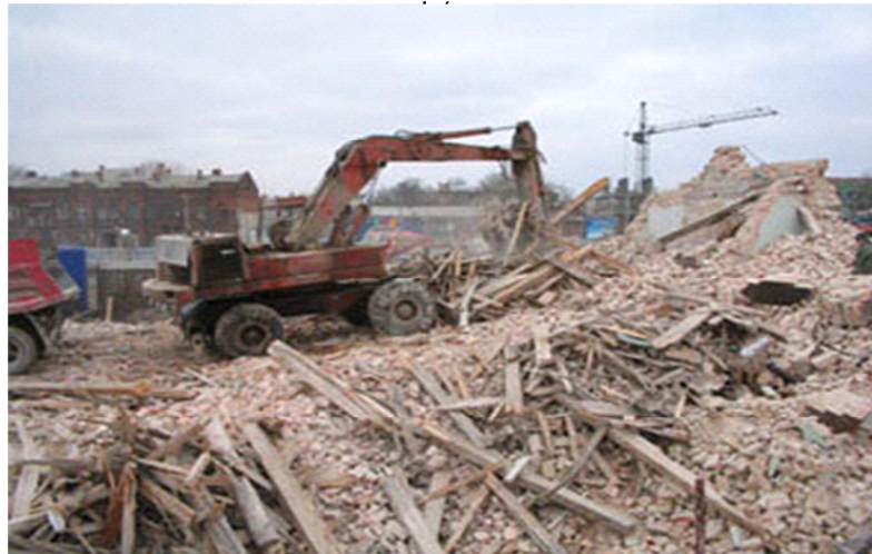
Рис. 2. Малопродуктивна робота екскаватора з ковшем на розбиранні зруйнованих будинків у центрі Дніпропетровська (реконструкція, 2006)
