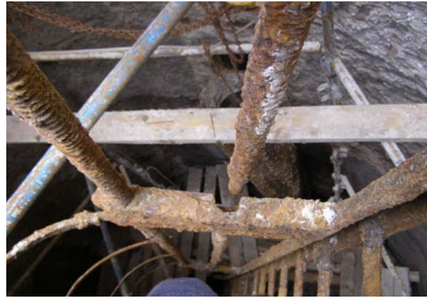
Рис. 3. Повреждения конструкций шахты № 10: а – разрушение железобетонной рубашки; б – коррозионный износ лестницы
