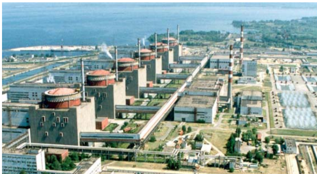
Рис. 3. Общий вид на Запорізькую АЭС с энергоблоками ВВЭР-1000
