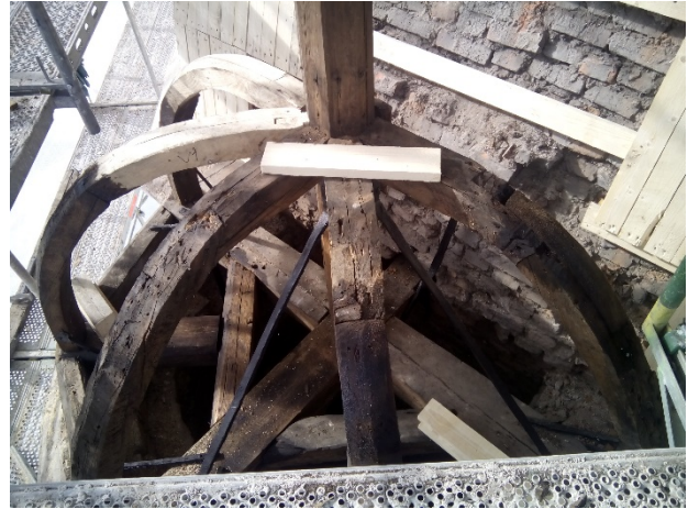
Рис. 3 – Пример протезирования конструкций главки в храме Пресвятой Богородицы (г. Тарту, Эстонская Республика)
