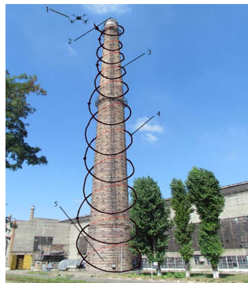
Рис. 10. Використання квадрокоптера для обстеження технічного стану димової труби: 1. - квадрокоптер; 2, 5. - частини труби; 3. - димова
