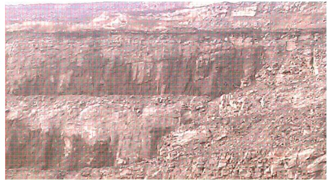
Рис. 1 г. Спарені уступи на південно-західному борті кар'єру ІнГЗК, поставлені в граничне положення методом контурного підривання ( \delta = 1 ) / Fig. 1 г. Paired ledges on the south western side of Inguletskyi GOK quarry that have been delimited by the contour blast method ( \delta = 2 )
