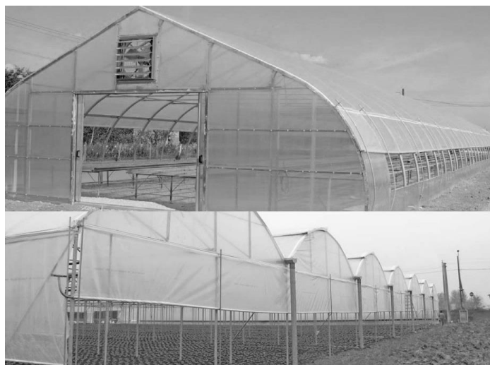
Рис. 2. Вентиляція через фронти конструкції теплиці
