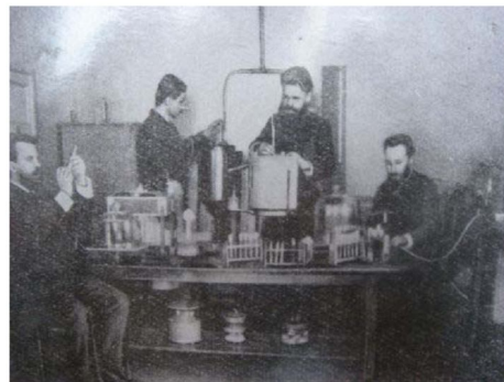
Рис. 2. Лабораторная установка для получения ионов серебра
