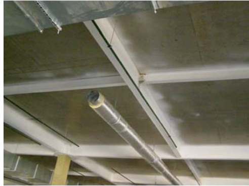
Рис. 2. Общий вид стальных балок и колонн каркаса
