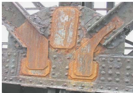
Рис. 8. Восстановление несущей способности узлового соединения
