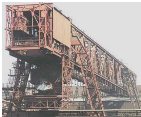
Рис. 1. Общий вид РГК-2 со стороны шарнирной опоры
