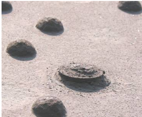
Рис. 5. Восстановление головки заклепки постановкой шайб на электросварке
