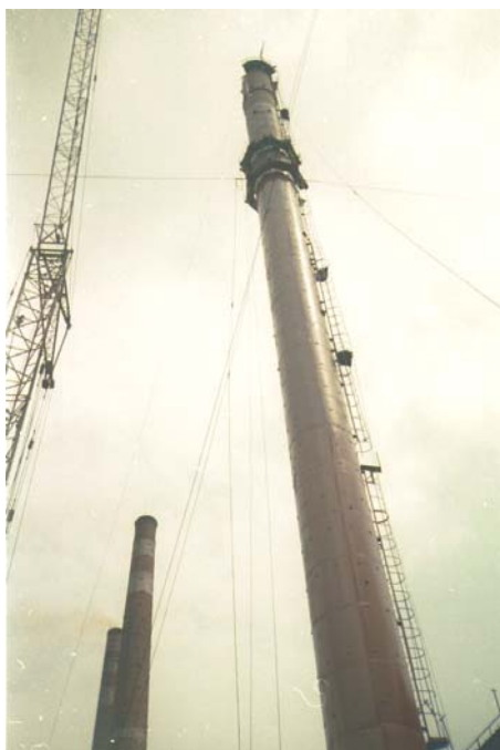
Рис. 1. Общий вид трубы в проектном положении
