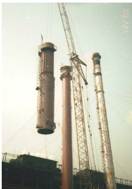
Рис. 2. Монтаж верхней части трубы краном СКГ-100
