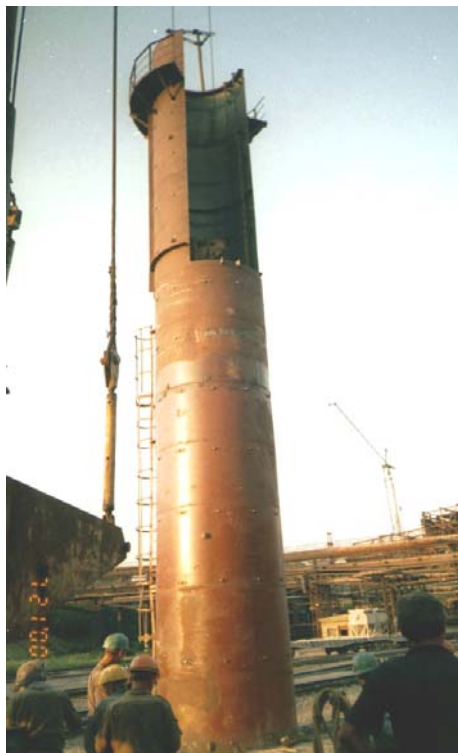
Рис. 3. Верхняя часть трубы в момент центровки перед подъемом в монтажное положение
