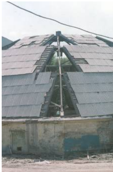
Рис. 2. Искривленное ребро купола
