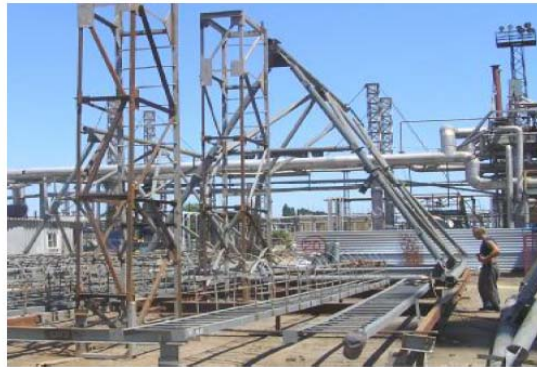
Рис. 7. Конструкции башни на стенде укрупнительной сборки
