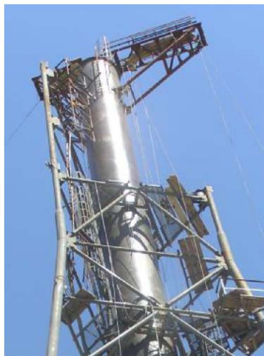
Рис. 6. Общий вид расположения монтажного механизма.
