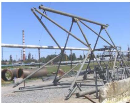
Рис. 3. Монтажный элемент башни после укрупнительной сборки
