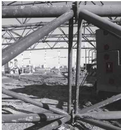
Рис. 7. Монтажне з'єднання верхнього пояса ферми конструкції на будівельному майданчику
