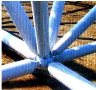
Рис. 5. Узел соединения системы «MERO»
