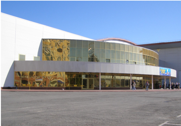
Рис. 2. Фрагмент фасада Международного выставочного центра в Киеве
