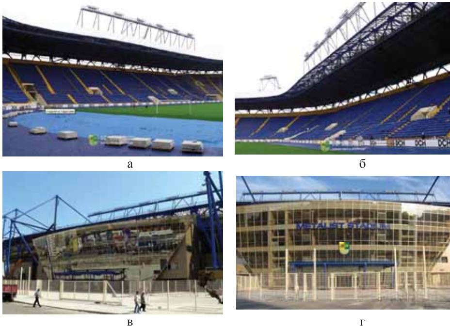
Рис. 2. Система освещения стадиона ОСК «Металлист» (а, б) и многофункциональный корпус с подтрибунными помещениями коммерческого назначения (в, г)
