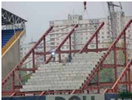
Рис. 6. Общий вид восточной трибуны в процессе строительства
