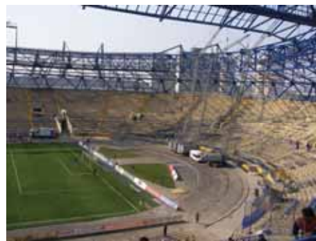
Рис. 7. Общий вид западной и северной трибун в процессе реконструкции
