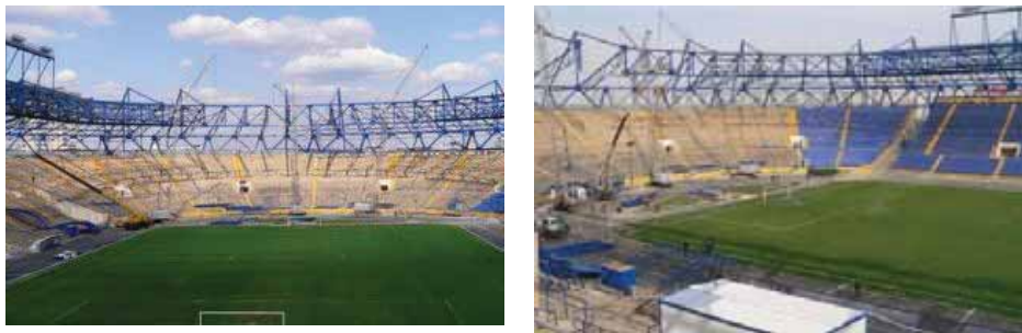
Рис. 8. Общие виды металлических конструкций покрытия стадиона ОСК «Металлист» в процессе монтажа
