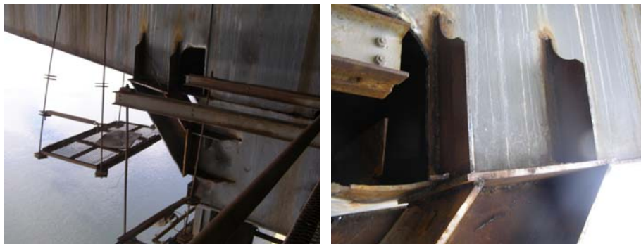
Рис. 4. Усиление нижних поясов металлических несущих ригелей
