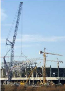
Рис. 11. Установка монтажного блока в проектное положение
