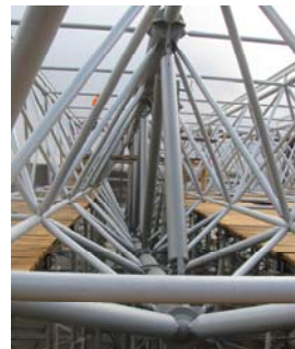
Рис. 10. Укрупнение металлических конструкций покрытия на стендах в монтажные блоки
