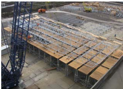
Рис. 10. Укрупнение металлических конструкций покрытия на стендах в монтажные блоки
