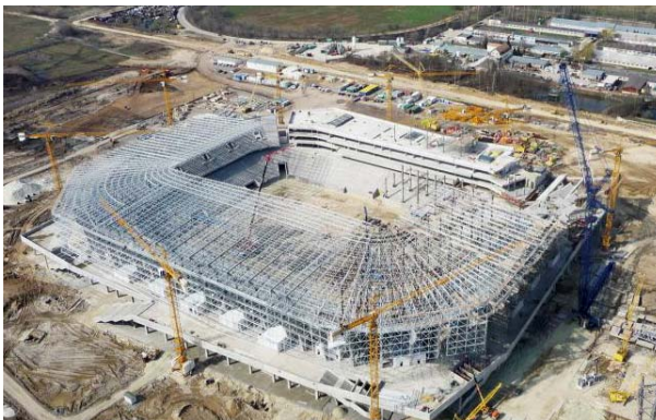
Рис. 13. Общий вид в период монтажа конструкций покрытия стадиона «Арена-Львов»
