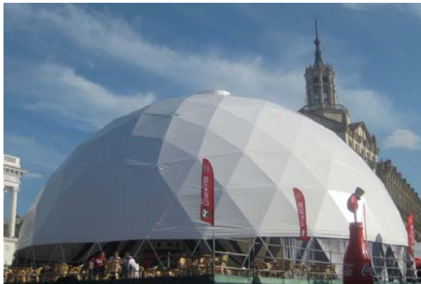
Рис. 1. VIP-шатро на Майдані незалежності у фан-зоні м. Києва під час проведення чемпіонату «Євро-2012» – геодезичний купол з розбиванням 6V
