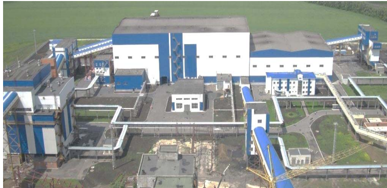
Рис. 1. Общий вид производственной площадки ОФ «Свято-Варваринская» ПрАО «Донецксталь» – металлургический завод (в центре – главный корпус)
