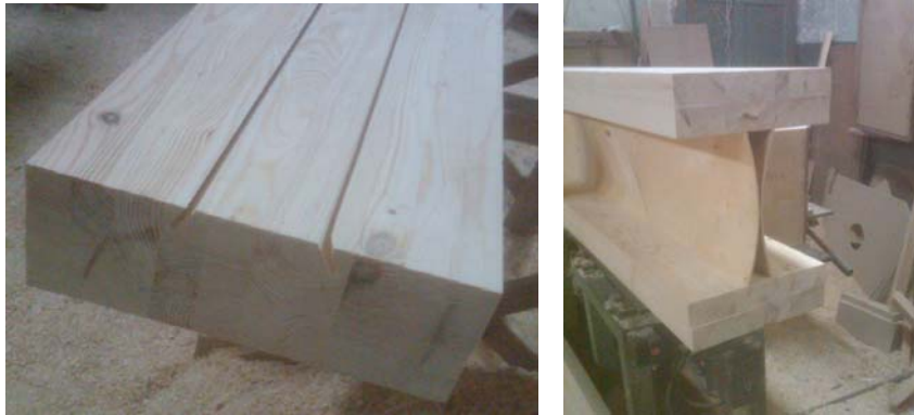
Рис. 1. Новая балочная конструкция в процессе изготовления
