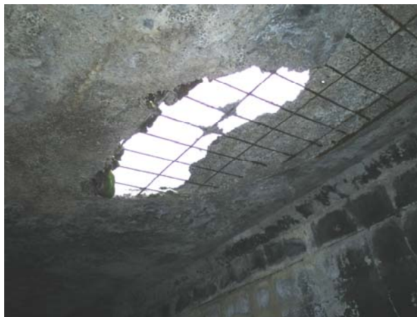
Рис. 6. Вигляд плити перекриття після кондиціонування на відкритому повітрі
