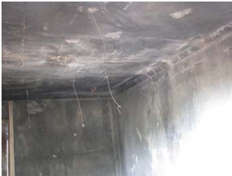
Рис. 4. Вигляд плити покриття після вогневих випробувань
