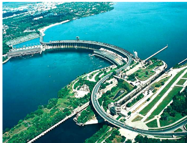
Рис. 1. Автодорожный переход по сооружениям ДнепроГЭС
