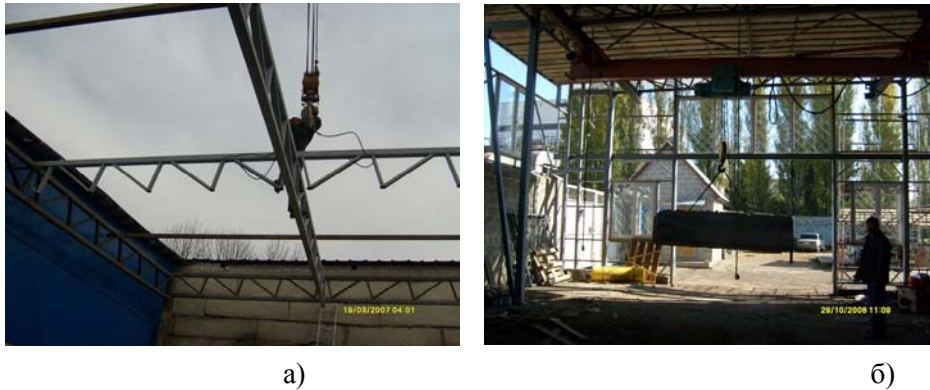
Рис. 2. Монтаж перекрестных ферм с бесфасоночными раскосными узлами (а) и их апробация при испытаниях подвесного крана грузоподъемностью 3,2 тонны
