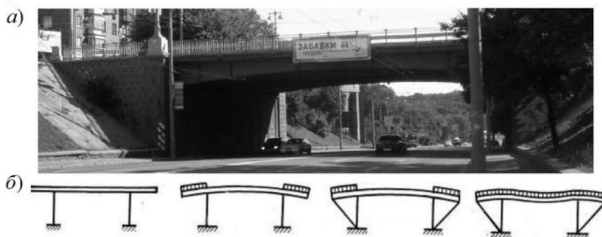
Рис. 18. Путепровод в Киеве: *а* – общий вид, *б* – этапы производства работ
