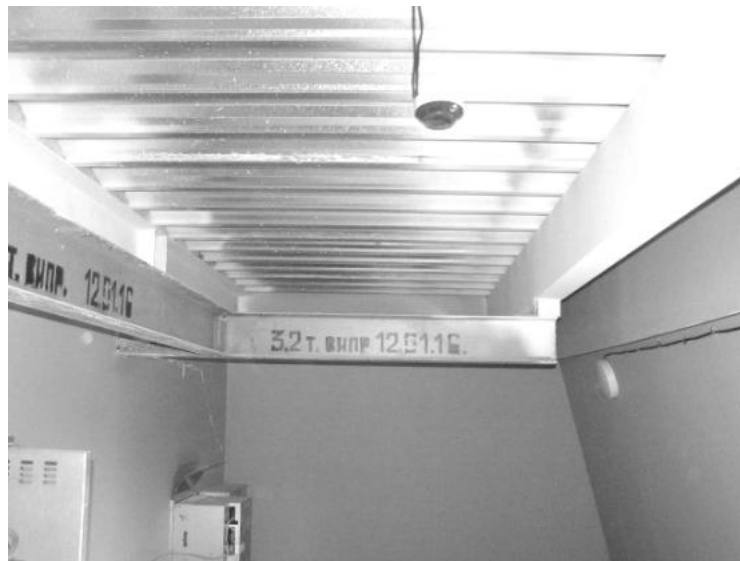
Рис. 9. Вигляд конструкцій покриття в машинному відділенні
