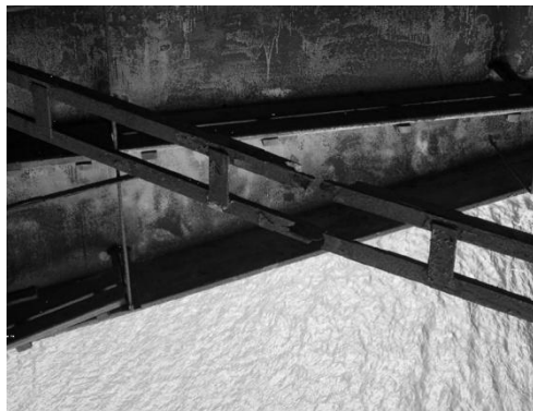
Рис. 6. Розрив в'язі в прогоні 16-17 внаслідок дії корозії
