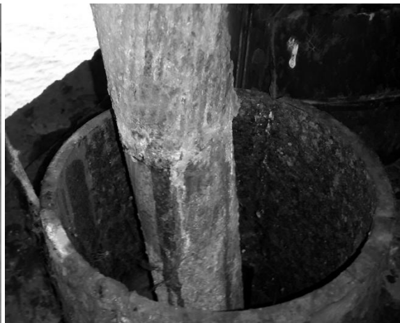
Рис. 15. Стан заанкерованих канатів вант для відтягування пілону
