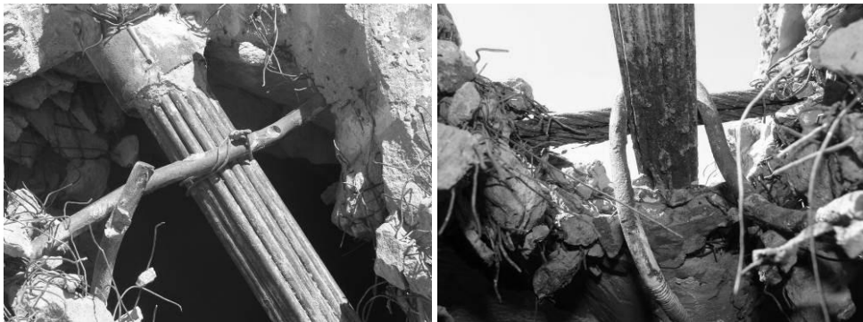
Рис. 3. Несна ванта покриття ККЗ «Україна» в гребеневій зоні: a – несна ванта в анкерній зоні з'єднання з аркою; б – вузол перетину ванти із стягуючими тросами, вид із приміщення глядацької зали
