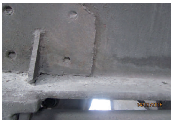
Рис. 6 – Накладки з тріщинами в зварних з'єднаннях з хребтовою балкою
