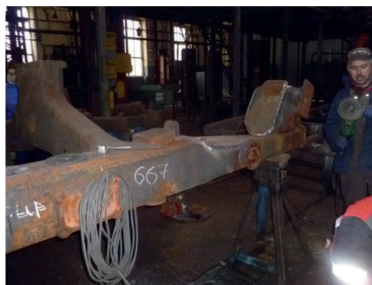
Рис. 5 - Робочий процес заміни силового кронштейну рами візка електропоїзду ЕР-9
