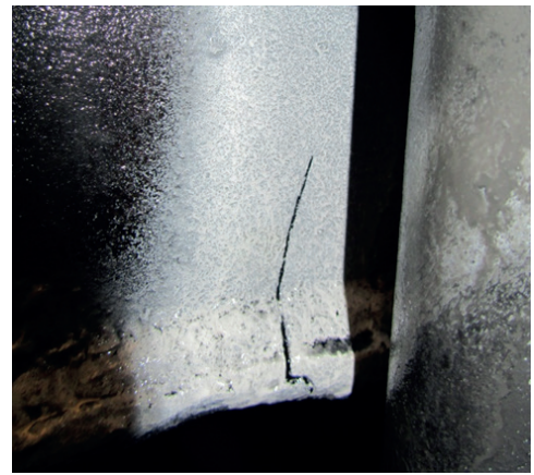
Рис. 3 – Тріщина в місці з'єднання поперечної балки рами візка електропоїзду серії ЕР1 і ЕР2 з допоміжною балкою боковини рами
