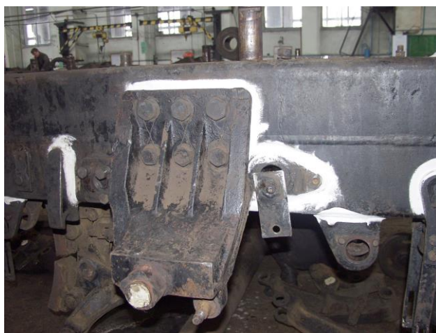
Рис. 6 - Крейдо-гасова дефектоскопія зварних з'єднань рами візка електровоза
