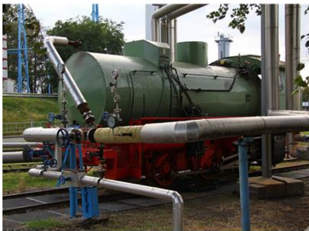
Мал. 7 – Загальний вигляд пункту екіпірування пароаккумуляторних локомотивів
