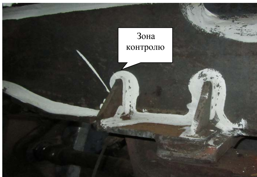
Рис. 2 – Приклад використання крейдо-гасової проби на несучих металевих конструкціях РС
