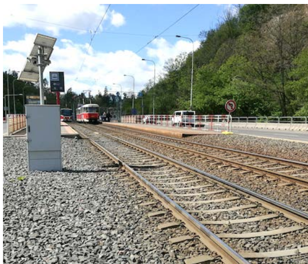
Рис. 2 - Стационарный электрический путевой модуль (EGD) с жидким модификатором трения
