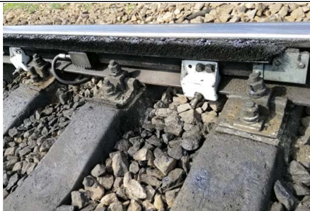
Рис. 6 - Путевой жидкостный лубрикатор
